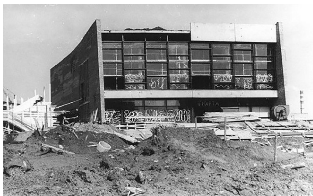
Кинотеатр «Парма» строится. 1973 г.
