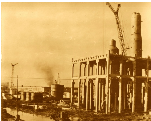
ЛПК строится. 1962 год
